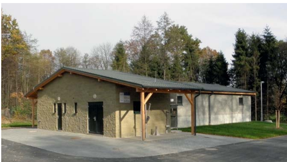
Stávající čistírna odpadních vod v ulici Ve Strži, do níž budou svedeny odpadní vody také v II. etapě odkanalizování Horních Datyň.
