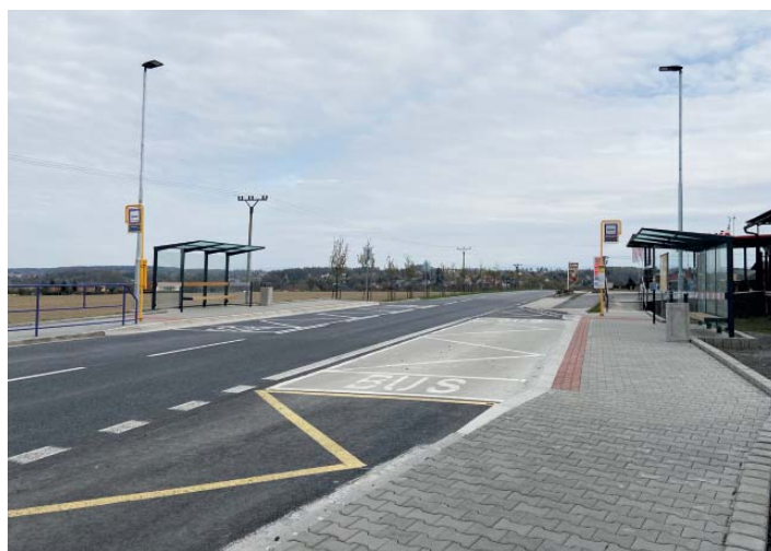
Nové autobusové přístřešky u zastávky Důlnák vybudované v rámci opravy místní komunikace ul. Rakovecká. Foto: MěÚ
