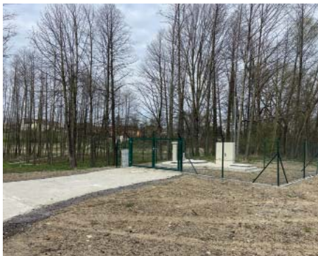
Čerpací stanice (ČS3) splaškové kanalizace, ulice Václavovická. Foto: MěÚ
