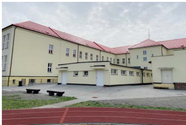
ZŠ Masarovo nám. 192 – Přístavba šaten a oprava fasády.
