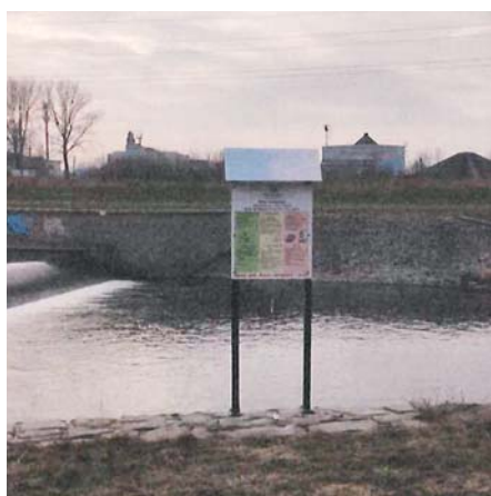
Situace na jezu Hrabová v říjnu 2019 a lednu 2020. Foto: Povodí Odry
