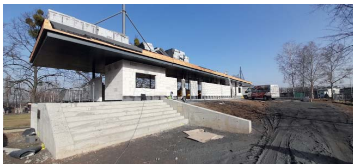
Nová budova koupaliště se už rýsuje, bohužel její dokončení se o něco oddálí.
