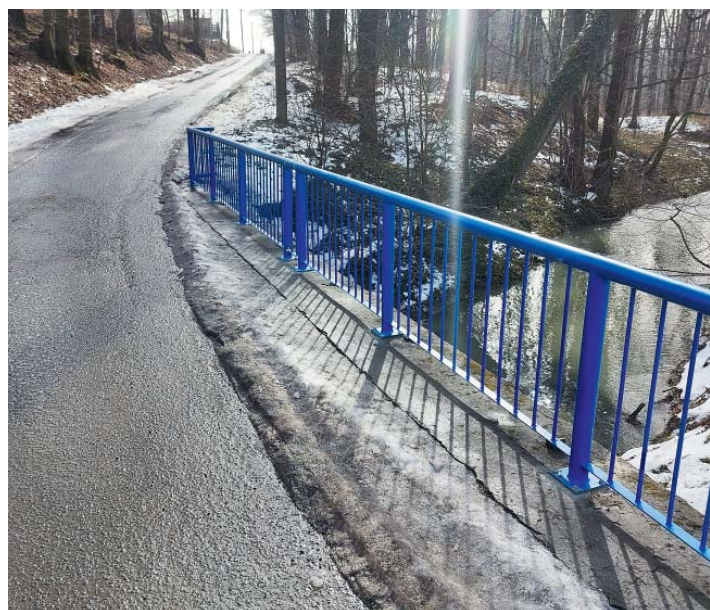
Nové zábradlí na mostě v Rakovecké ulici. Je hezčí i bezpečnější.
