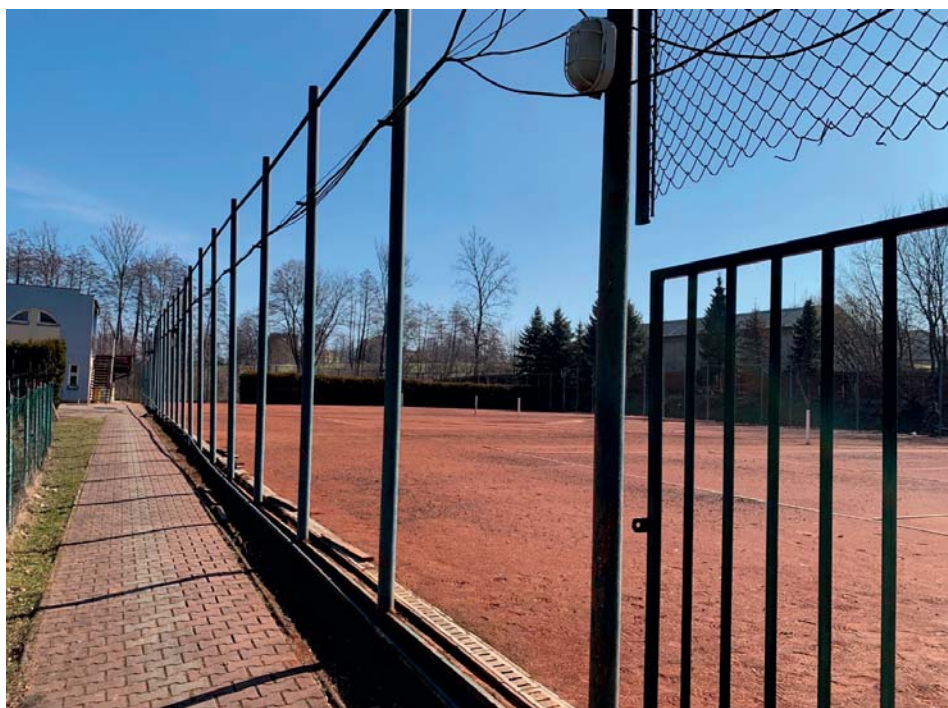
Na tenisových kurtech TC Biocel Vratimov probíhá výstavba nového plotu. Akci podpořilo město Vratimov. Foto: TC Biocel Vratimov
