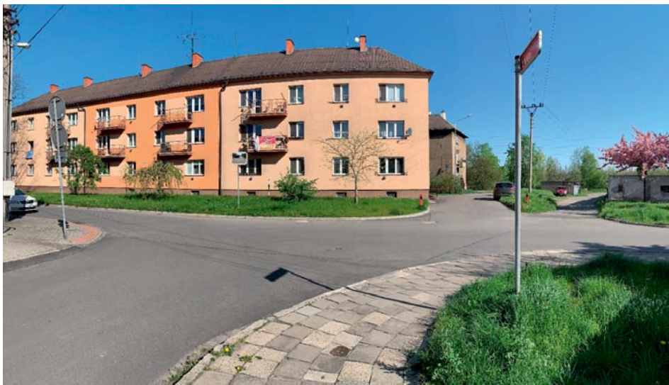
K vyšší bezpečnosti na křižovatce ulic Na Hermaně a Sokolské přispěje instalace zrcadla.
