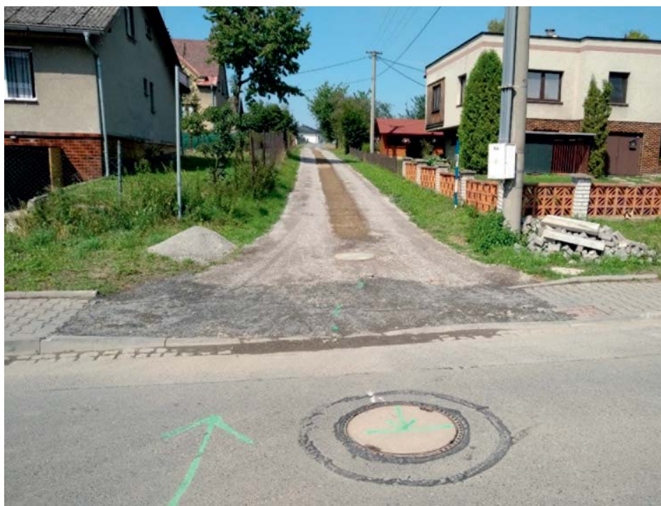
Ukončená výstavba stoky F4 na ul. Za Humny, Horní Datyně.
