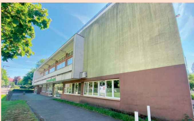
Vzhled fasády před započetím čistících prací.
