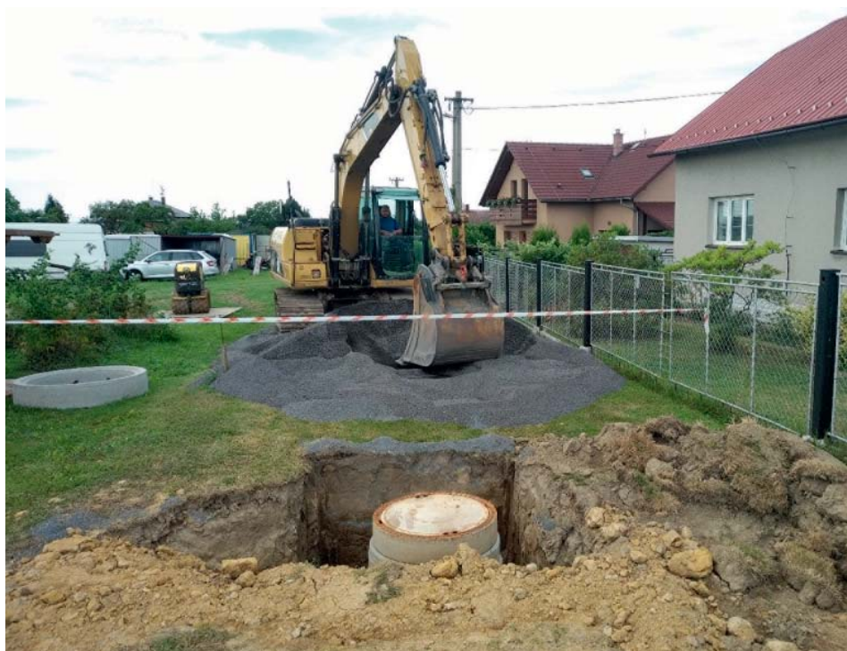
Začátek kanalizace na ul. Souběžná, Horní Datyně, stoka I1.
