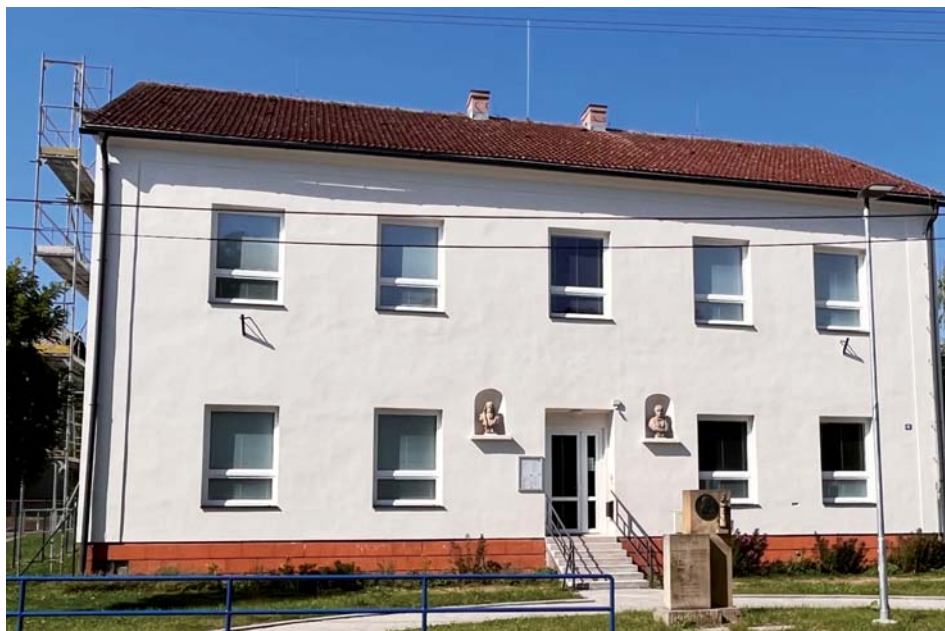
Základní školu v Horních Datyních čekají opravy.
