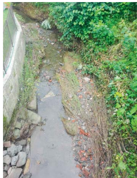
Stavební suť do vodního toku nepatří.
