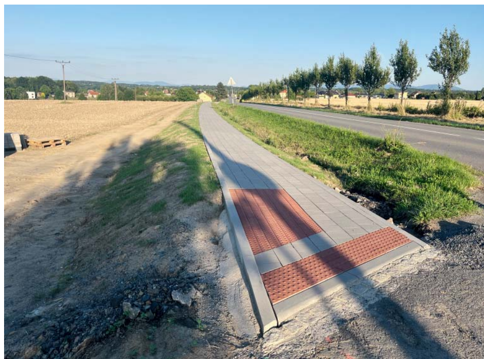
Výstavba nového chodníku na ul. Datyňská.
